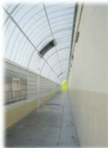
Galería de la cárcel de Navacarnero denominada 'M-30'.
