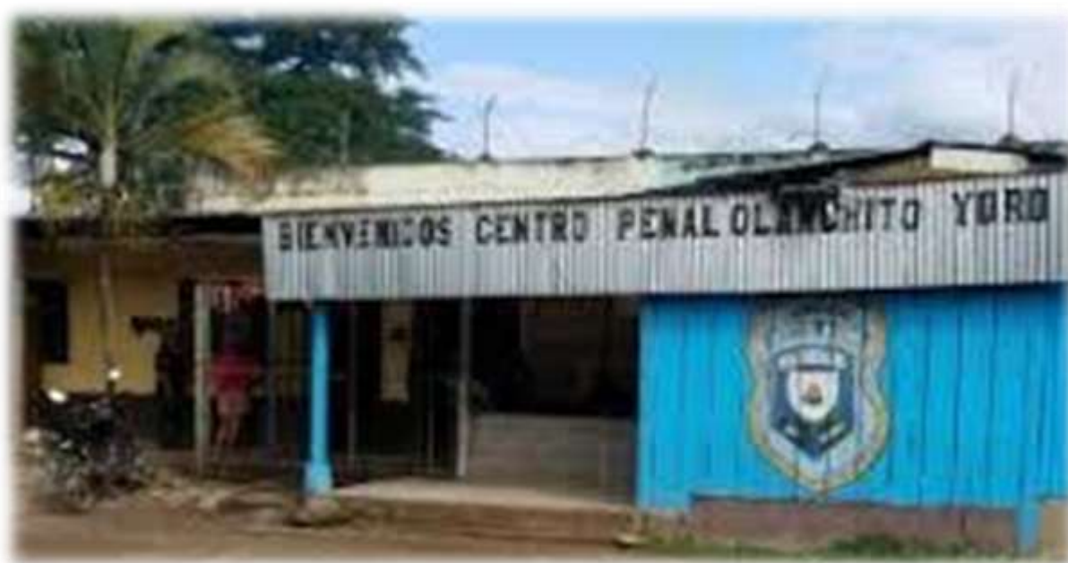
Fachada principal del Centro Penitenciario de Olanchito
